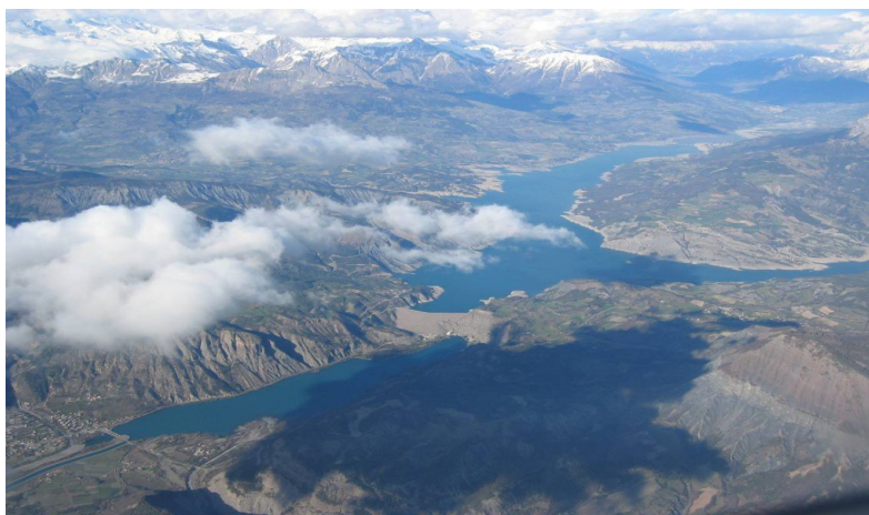
Le barrage et le lac de Serre-Ponçon au confluent de la Durance et de L'Ubaye ouvrage amont de l'aménagement hydroélectrique construit en 1957-59. Au fond les montagnes enneigées qui l'alimentent en été. Mais demain ?
